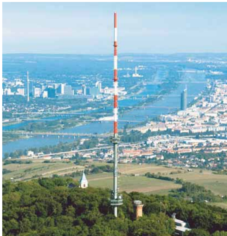
Sendemasten wie dieser am Kahlenberg können durch die Vergabe des 800 MHz Bandes an die Mobilfunkler gestört werden – vor allem ärgerlich für die Fernsehkunden.
