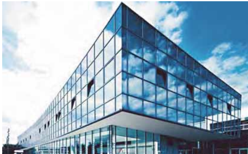
Messezentrum Salzburg: Trotz Umbauarbeiten in den Hallen 10 bis 15 wird die Branchenmesse ungestört in den Hallen 1 bis 9 über die Bühne gehen.
