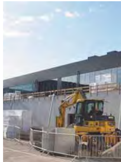
Neubau: Für die Futura 2012 wird bereits die neue Mehrzweckhalle zur Verfügung stehen.
