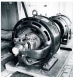
Rotierender Umformer einer elektrischen Lokalbahn, im Vordergrund der Generator für Gleichstrom
