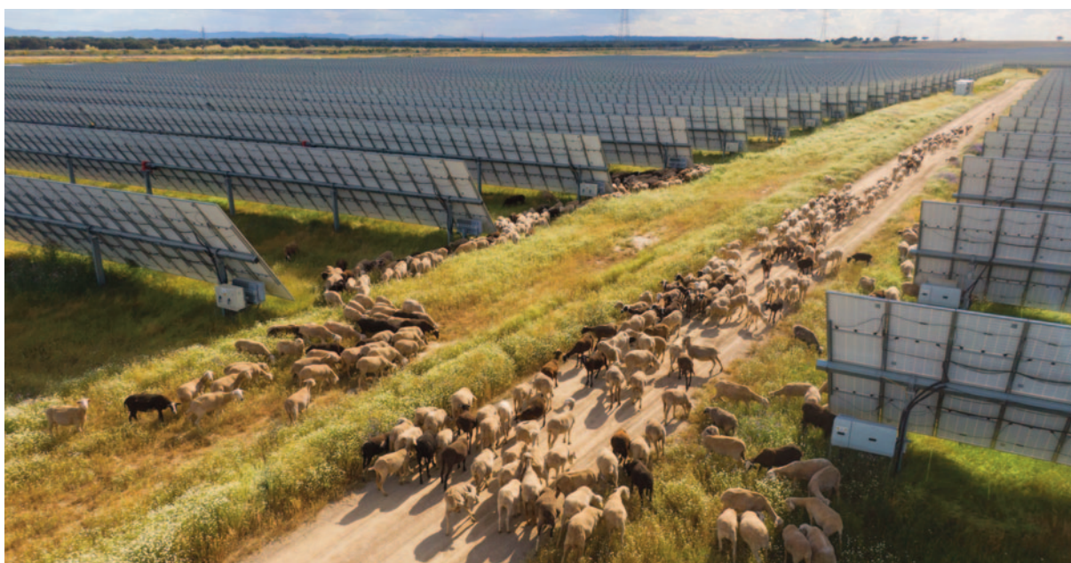
200 MW, Alcalá de Guadaíra, Seville, Spain.
